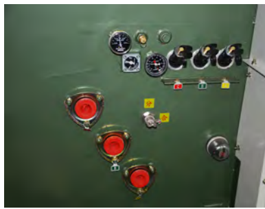
S11型10kV三相双绕组无励磁调压配电变压器
